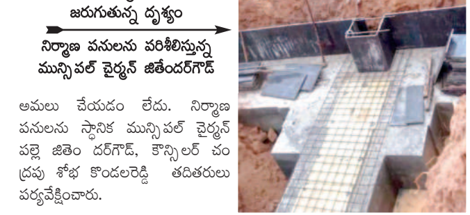
నిర్మాణ పనులను పరిశీలిస్తున్న మున్సిపల్ చైర్మన్ జితేందర్ గౌడ్
